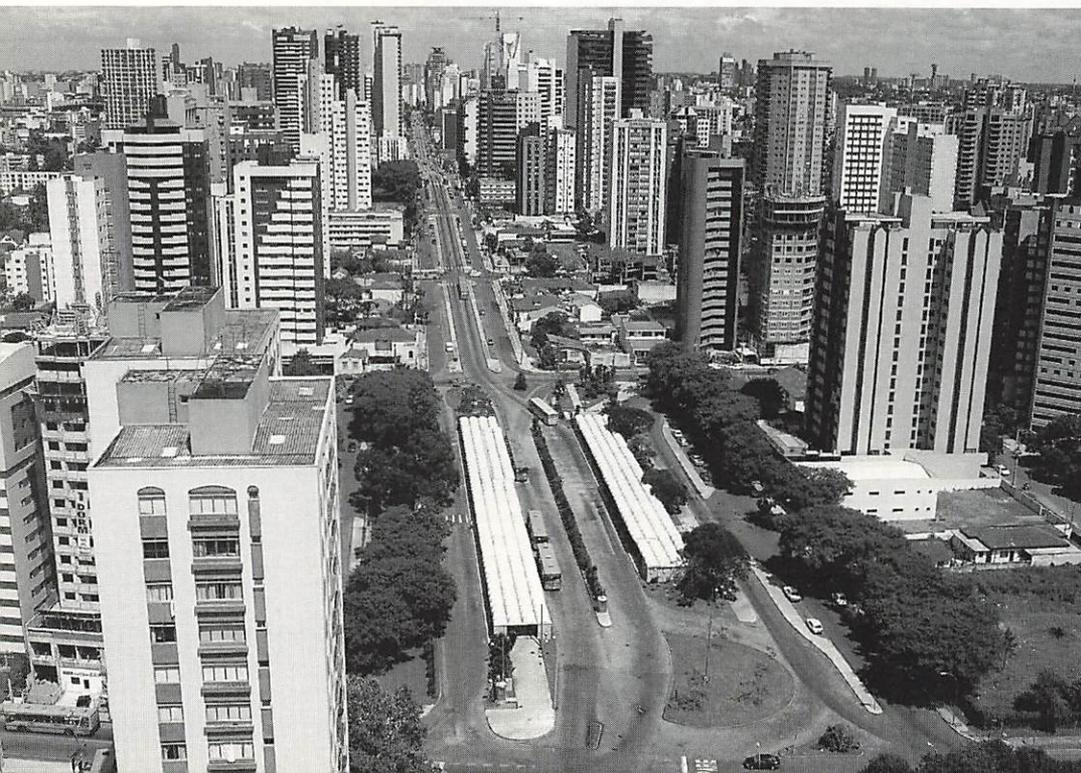
Beidseitig zu dieser Zentralstraße verlaufen im Abstand von einem Bebauungsblock zwei Einbahnstraßen mit jeweils vier Spuren für den motorisierten Individualverkehr in die Innenstadt bzw. in Richtung Peripherie. Entlang dieser Strukturachsen konnte man in Curitiba durch gesetzliche Regelung der Flächennutzung eine dichte Besiedlung
