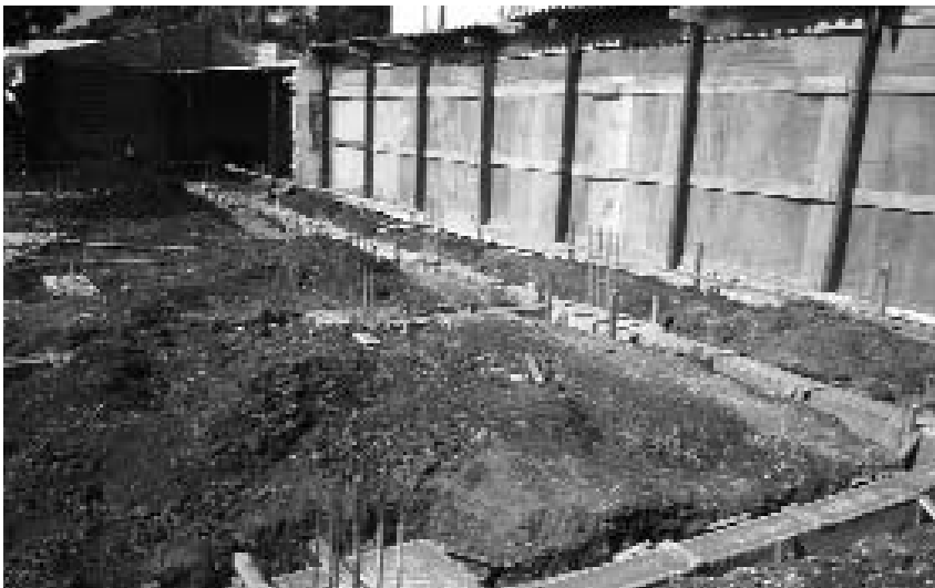
Bauarbeiten des Ausbildungszentrum
