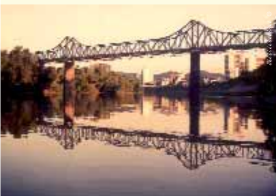
Ponte de ferro
