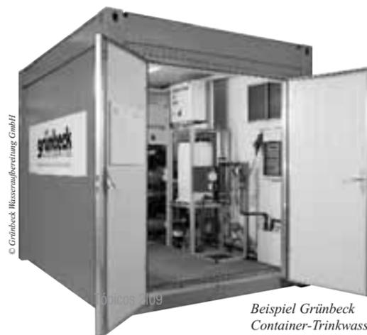
Beispiel Grünbeck Container-Trinkwasseraufbereitungsanlage
