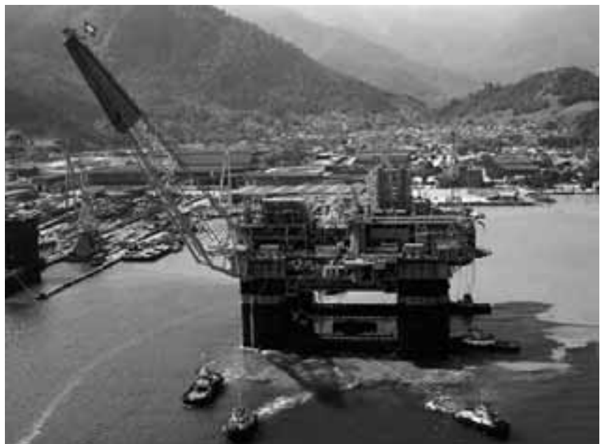
Construção de plataforma para exploração de petróleo pré-sal, um setor que movimenta seguros de grande risco
