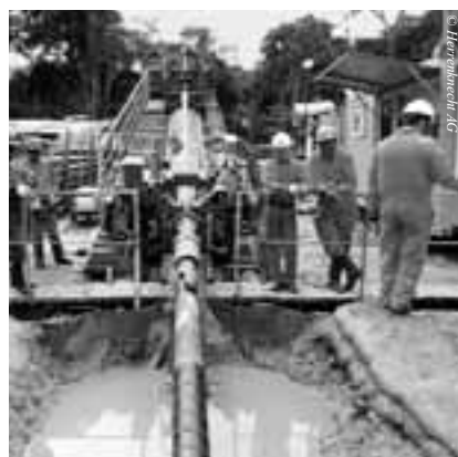
Pipelineverlegung in Brasilien: Herrenknecht-HDD-Rigs kamen für bis zu 1.800 m lange Flussquerungen zum Einsatz.
