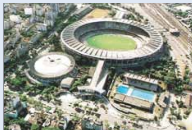
Rundumerneuerung des Maracanã-Stadion
