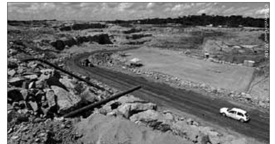
Bauarbeiten am künftigen Wasserkraftwerk Santo Antônio am Rio Madeira im Bundesstaat Rondônia
