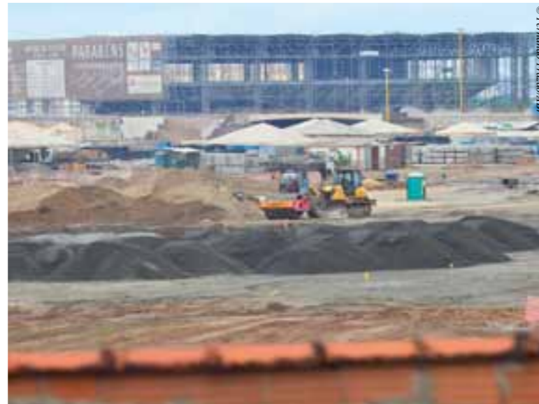
Canteiro der obras das Olimpíadas
