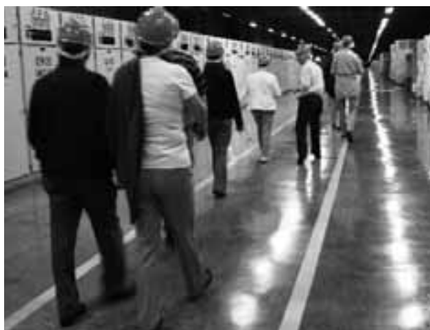
Exkursion: In der Schaltzentrale des Wasserkraftwerkes Itaipu
